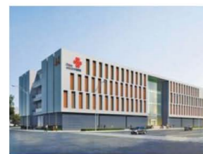
廊坊联通数据库项目
