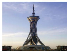
河南广电发射塔工程
