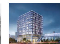
东阳妇幼保健院保健楼
